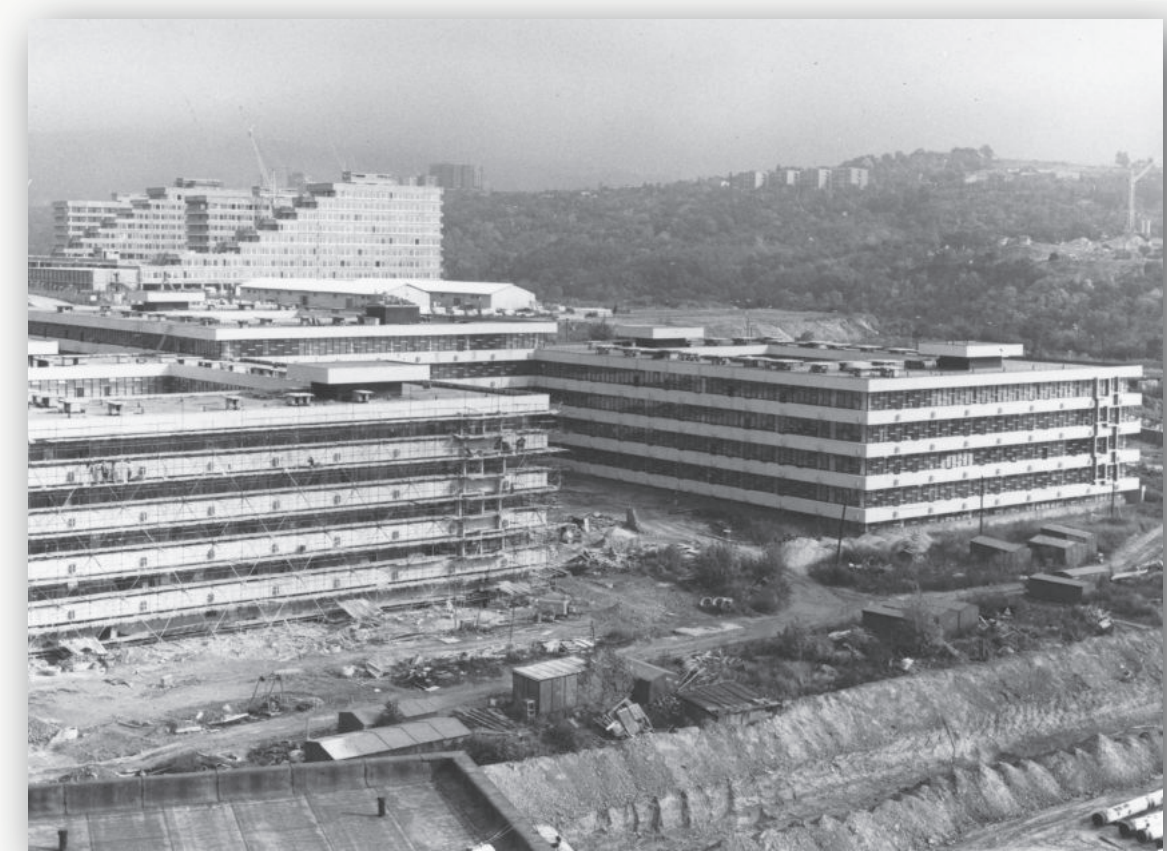
Výstavba pavilónov PríF UK v Mlynskej doline, v pozadí budovy Elektrotechnickej fakulty Slovenskej vysokej školy technickej v Bratislave
