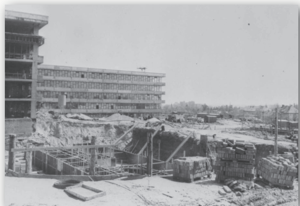
Stavebná jama posledného pavilónu PríF UK
