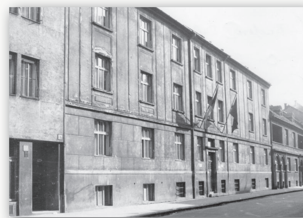
Budova dekanátu PríF UK na Moskovskej ulici č. 1
