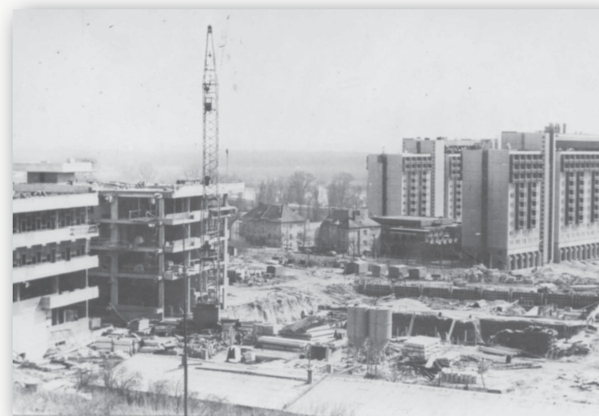
Zakladanie stavby ďalšieho z pavilónov PríF UK, v pozadí univerzitný internát Družba
