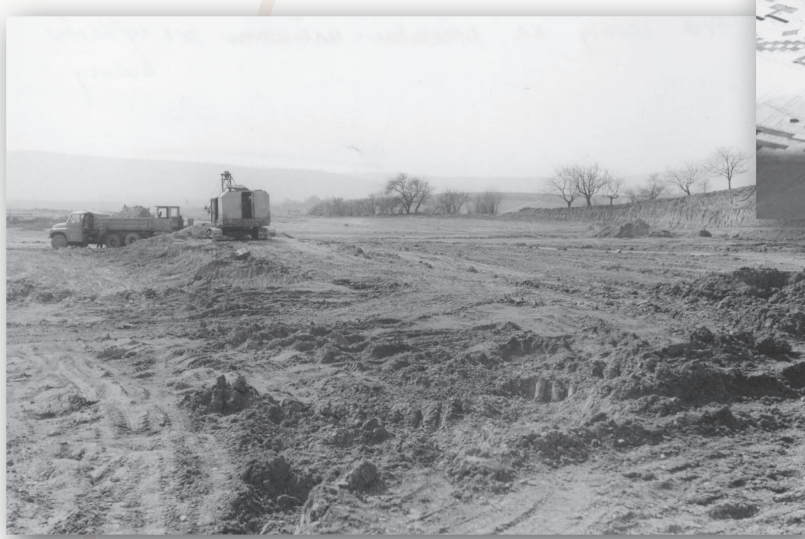
Prvé úpravy na pozemku určenom na výstavbu areálu Prírodovedeckej fakulty UK v Bratislave – Mlynskej doline, november 1966
