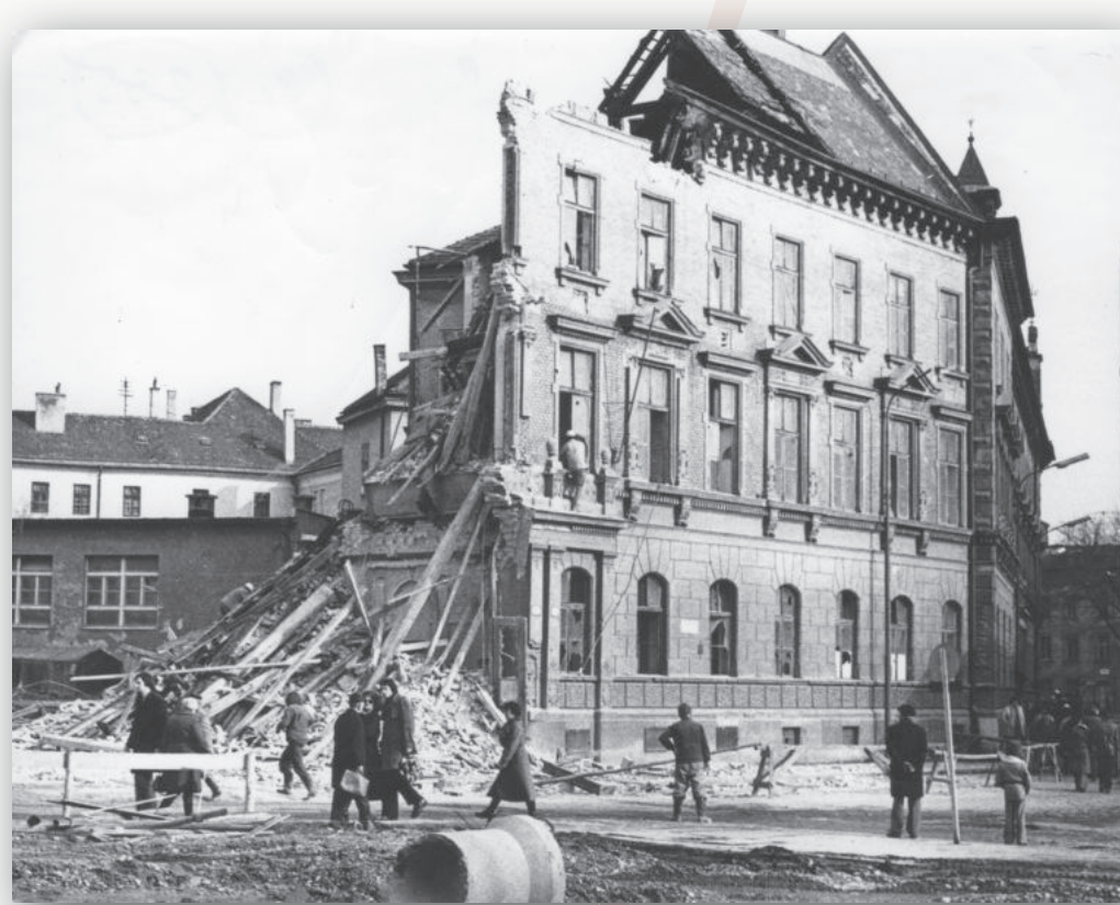
Búranie budovy PríF UK na Šmeralovej ulici (dnes Kozia)
