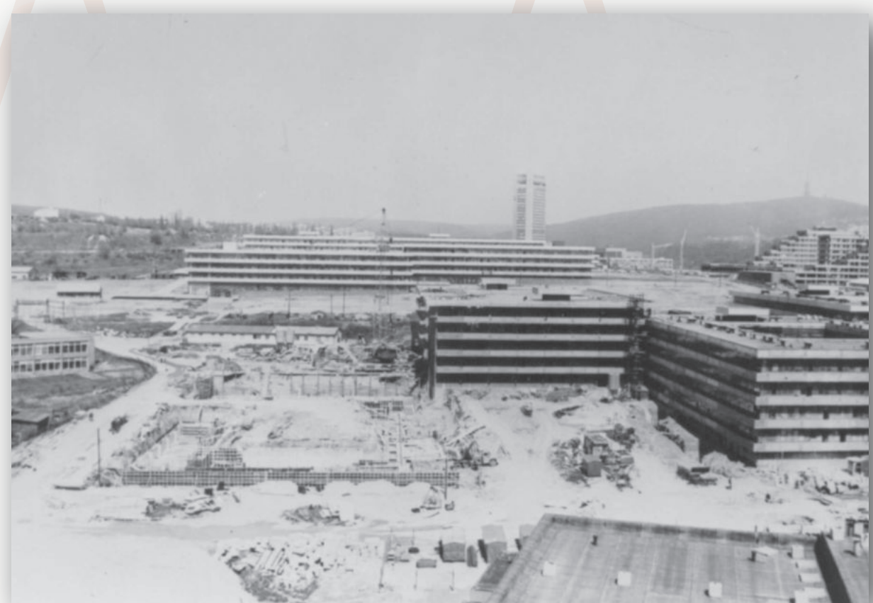
Zakladanie stavby ďalšieho z pavilónov PríF UK, v pozadí pavilón fyziky a výšková budova vtedajšej Československej televízie, štúdio Bratislava
