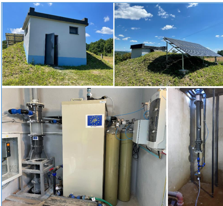
Obr. 1 Rekarbonizačný reaktor na vodnom zdroji Devičie (foto: Cvečková, 2022).
