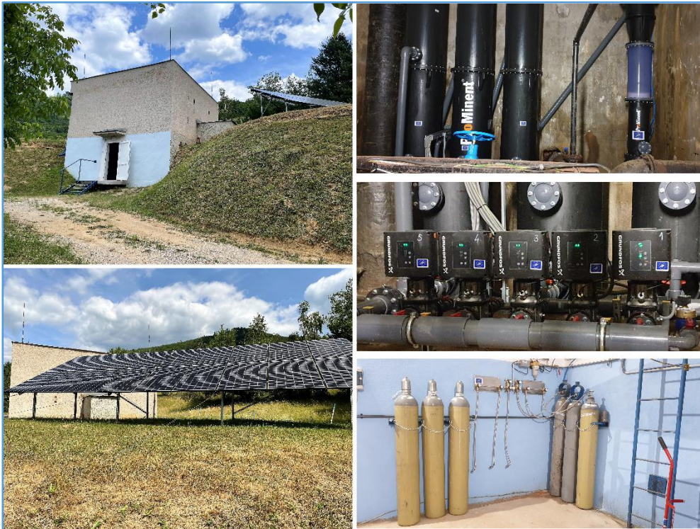
Obr. 2 Rekarbonizačný reaktor na vodnom zdroji v obci Kokava nad Rimavicou (foto: Cvečková, 2022).
