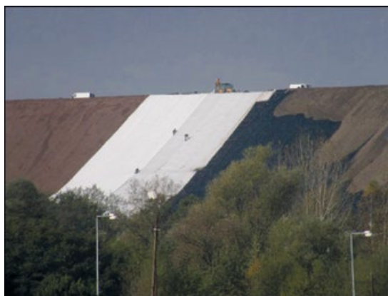
Dnes už historická snímka izolácie skládky odpadov po spracovaní bauxitu v Žiari nad Hronom.
