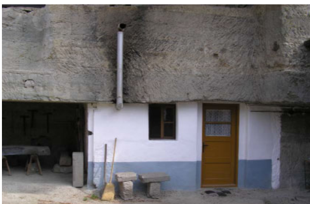
Obydlia v Brhlovcach sú vytesané do vulkanického tufu a vulkanického tuftu. Obe horniny sa zaraďujú medzi sedimentárne, avšak ich významnú zložku tvorí popol zo sopečnej činnosti.
