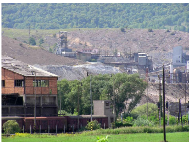
Hlbinná ťažba magnezitu v Lubeníku.
