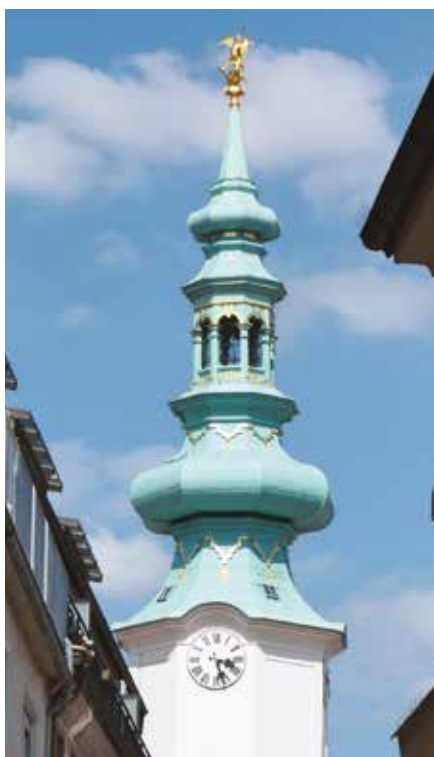
Obnovená strecha Michalskej veže v Bratislave je pokrytá novým medeným plechom s umelo vytvorenými koróznymi vrstvami medi. Vnútorne sú z oxidov medi, vonkajšia zelená je z brochantitu. Podobne bola reštaurovaná aj strecha Dómu sv. Martina (vpravo).
