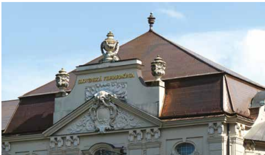
Nová hnedá medená strecha Slovenskej filharmónie v Bratislave. Jej transparentná antikorózna ochrana zabráni jej pokrytiu zelenou patinou.
