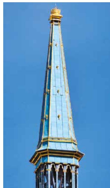
Obnovená strecha Michalskej veže v Bratislave je pokrytá novým medeným plechom s umelo vytvorenými koróznymi vrstvami medi. Vnútorne sú z oxidov medi, vonkajšia zelená je z brochantitu. Podobne bola reštaurovaná aj strecha Dómu sv. Martina (vpravo).
